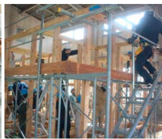
▲ 住宅施工実習 (住宅リフォーム技術科)
