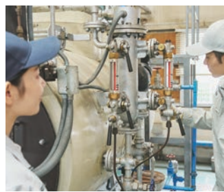
▲ ボイラー設備操作点検実習 (ビル管理技術科)
