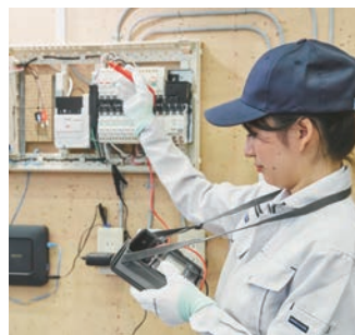
▲ 電気設備工事・竣工検査 (電気設備技術科)
