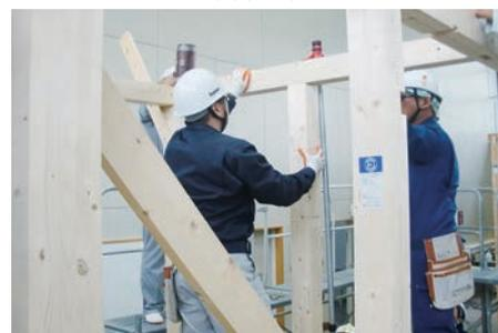
▲ 木造軸組工法による建物組立の実習
