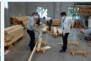
セミナーの様子 (実践的な木造軸組み工法の加工・組立技術)
