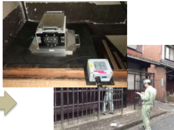
振動測定と家屋実測調査
