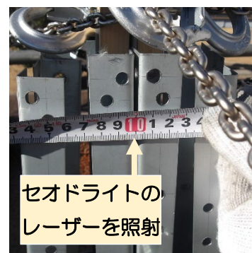
図6 第3節頂部の建入直し ※地墨を立ち上げたレーザーのポイントに、塔の芯を合わせる
