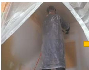
▲調湿・蓄熱塗料の吹付け施工の様子
