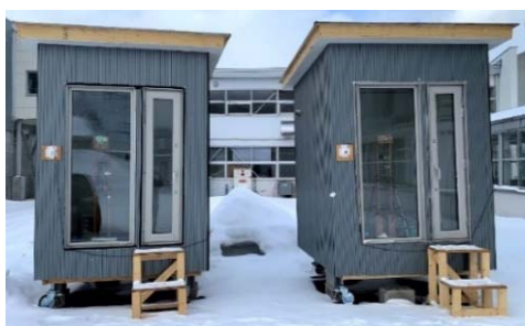
▲建設した実験モジュール
