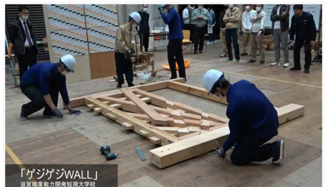
図2 学生による大会での耐力壁の組立解体
