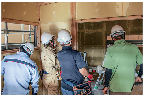
内装施工訓練の様子
