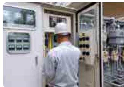
高圧受変電設備では、基礎知識(結線図、構成機器、機器の役割)と各継電器の試験方法について習得します。
