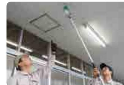
自動火災報知設備の施工・点検に関する技能及び関連知識を習得します。
