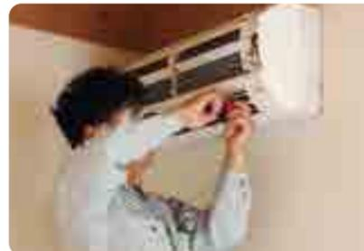
空冷式エアコンの冷媒の取り扱い。施工方法、空調機器の保守管理に関する技術と知識を習得します。
