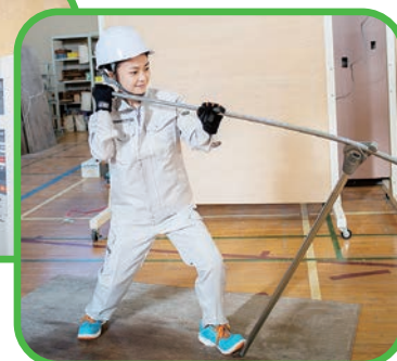
金属管工事作業
