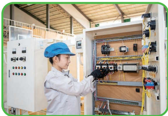
シーケンス制御配線作業
