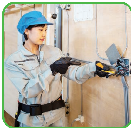
電気配線試験
