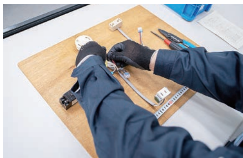
住宅設備施工
