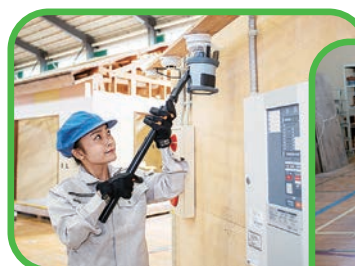
自動火災報知設備点検作業
