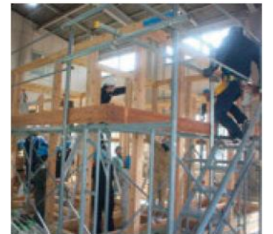
▲内装施工・改修実習 (住宅リフォーム技術科)
