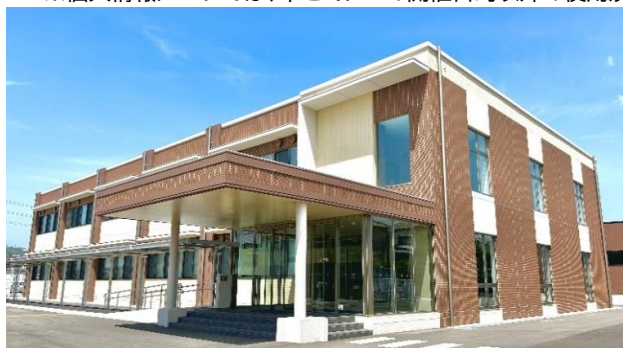
和歌山職業能力開発促進センター A棟
